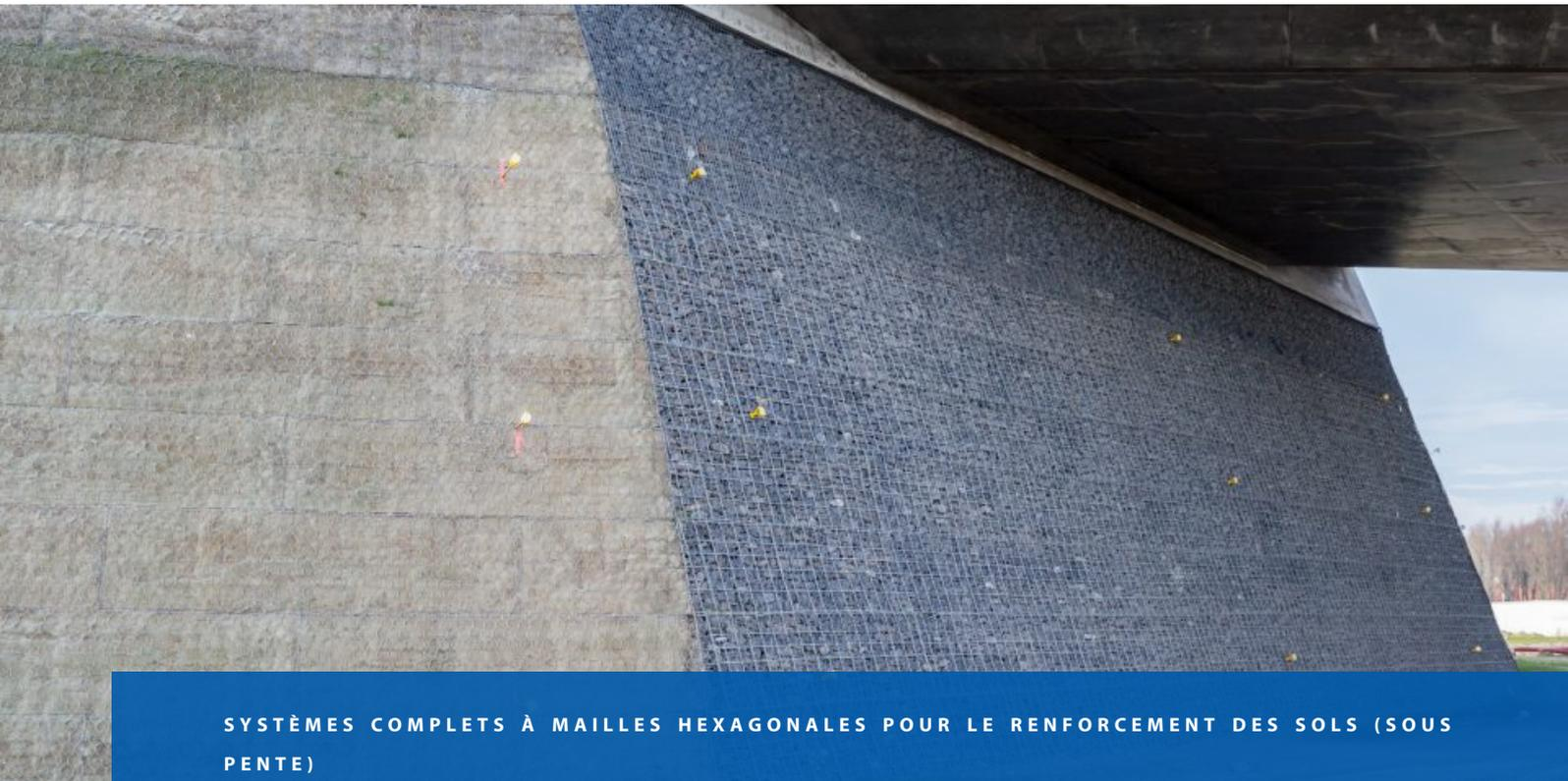
SYSTÈMES COMPLETS À MAILLES HEXAGONALES POUR LE RENFORCEMENT DES SOLS (SOUS PENTE)
