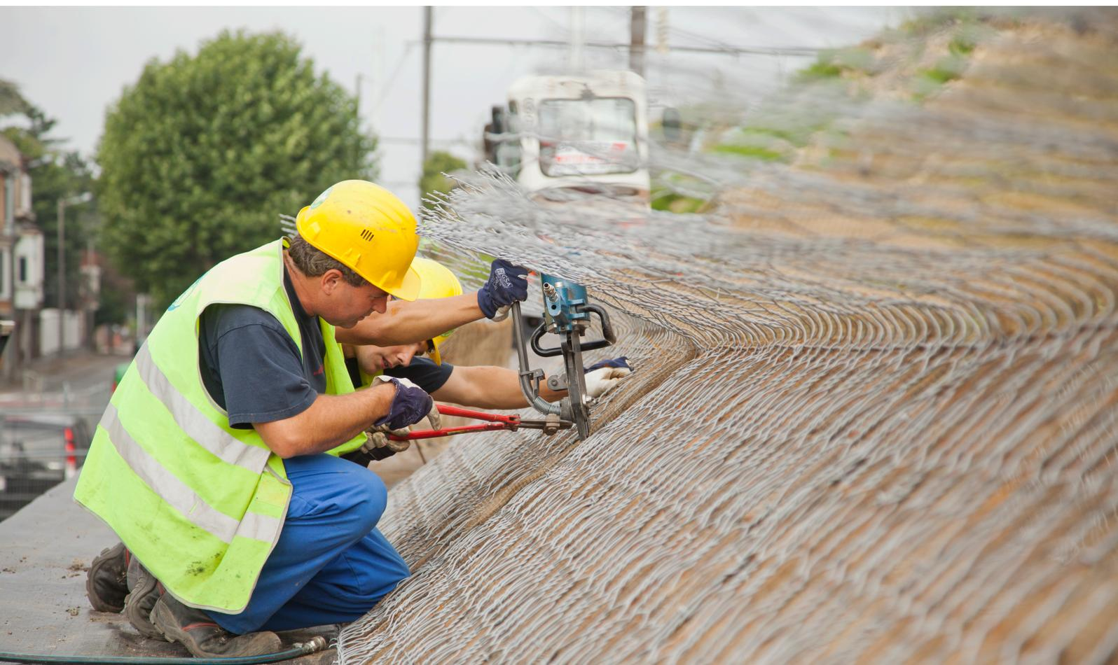
TREILLIS À MAILLES HEXAGONALES, RENFORCEMENT À PAREMENT VÉGÉTALISÉ
