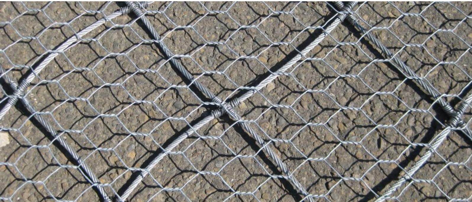
TREILLIS À HAUTE ABSORPTION D'ÉNERGIE
