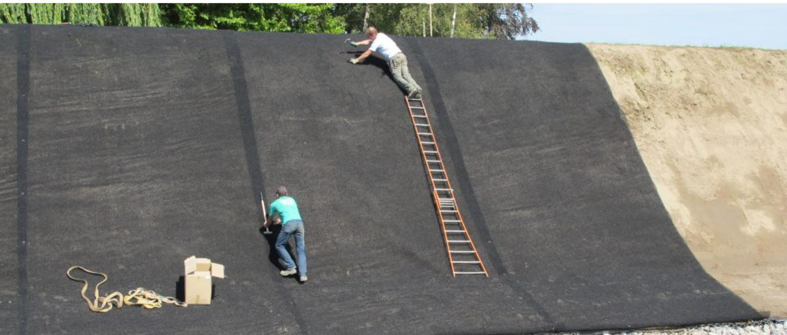
GÉOSPACEUR À STRUCTURE OUVERTE CONTRE L'ÉROSION DES TALUS
